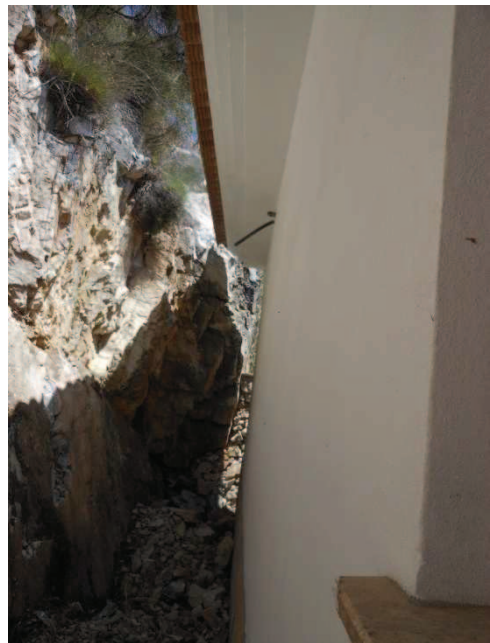
F. 2 Separación con el terreno de fachada noreste. Planta alta
