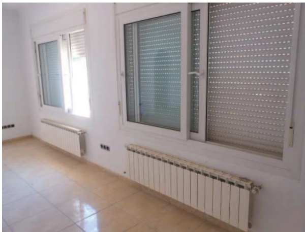
F. 1Carpinterías de PVC y radiadores para calefacción
